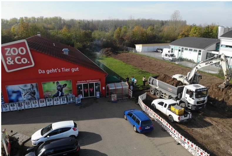
BU: 1. Spatenstich für die Erweiterung
